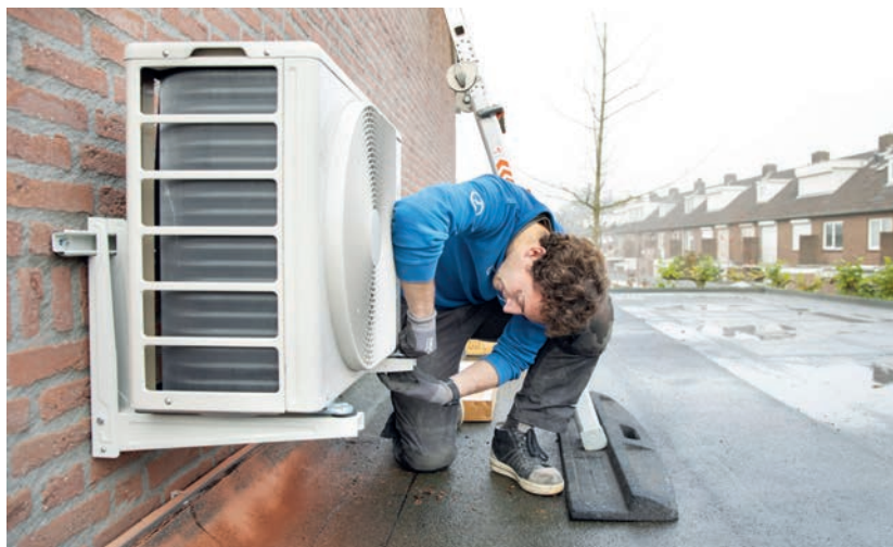
HeatTransformers installeert inmiddels ook zelf.
